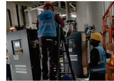
空压机热能收集利用改造现场
