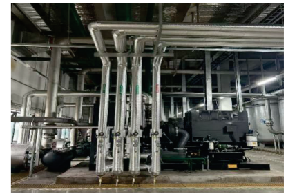
空压机热能收集利用改造现场
