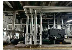
空压机热能收集利用改造现场
