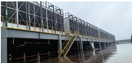
冷凝水收集回用至冷凝塔
